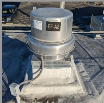
MARK EF-A1, A2, D1, D2 (4) UNITS MODEL 6B-101-6-X
